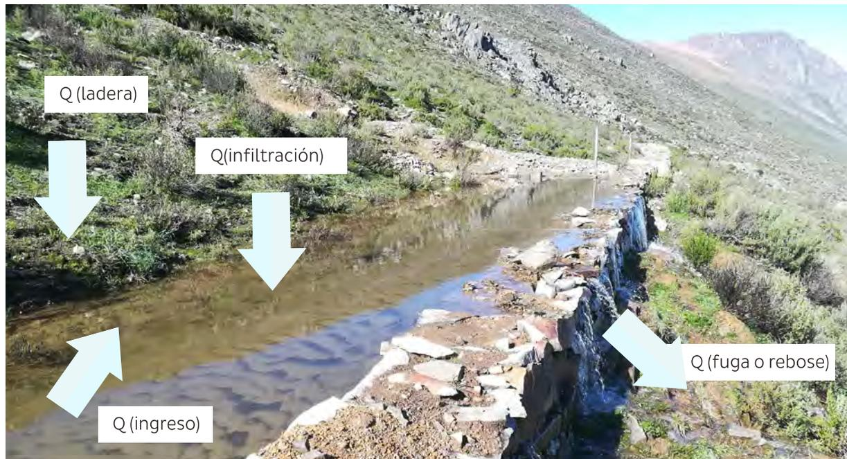
Figura N° 11: Esquema Caudales de Ingreso, Infiltración, Fuga y Aporte de Ladera
